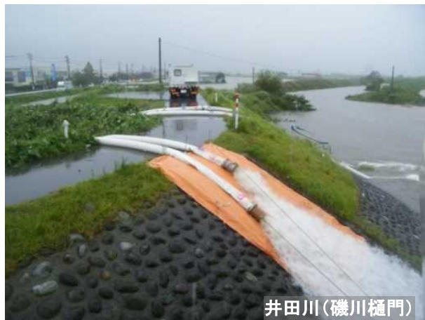
【排水ポンプ車による排水】
