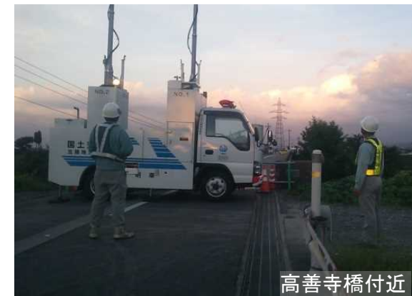
【平成25年9月洪水でのポンプ排水及び照明車配備】
