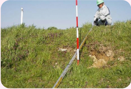
▲河川管理施設（堤防）の点検
