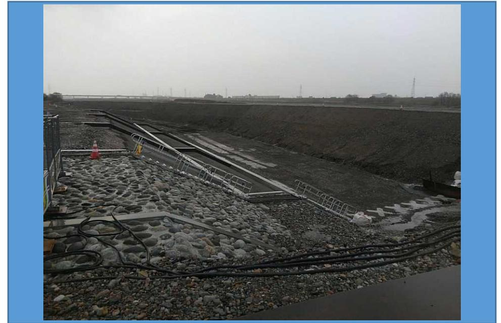
11月末にて掘削、仮締切、二次製品設置が完了して現在は練石張の施工を行っておりますが、下段部の掘削中及び法留基礎5型の施工時は法尻部の仮土留め設置や暗渠排水管設置を行う等、施工箇所からの湧水が多数あり湧水対策・処理に大変苦勞しました。
