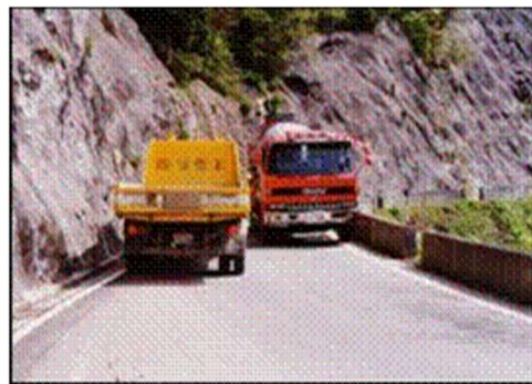
一般国道471号(現道)
