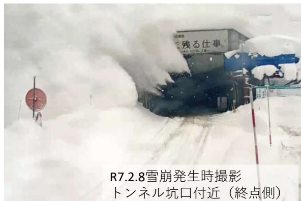
【赤松谷雪崩発生状況】
