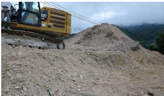
発生土の仮置き状況
