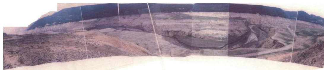
[平成6年渇水で貯水率が10%を下回った御母衣ダム(H6.9.6)(写真1-3)]
