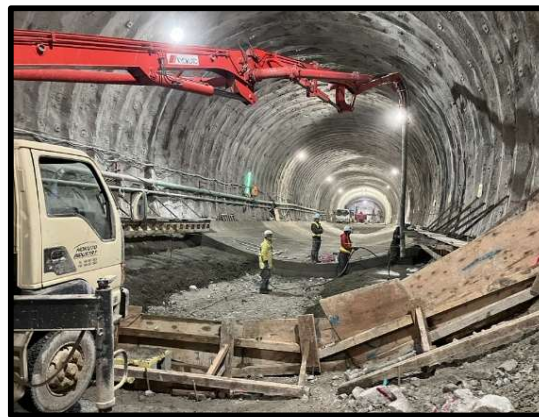
インバート打設状況
