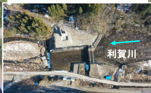
岩湫地区橋梁 令和7年11月時点
