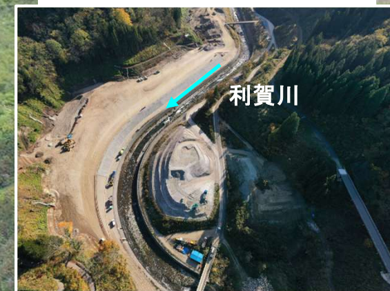
利賀地区盛土 令和7年11月時点
