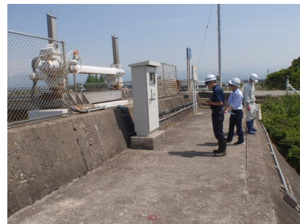
河川管理施設の点検
