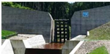
砂防堰堤工
