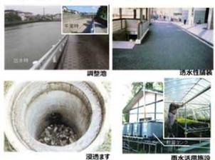
雨水貯留浸透施設の例
