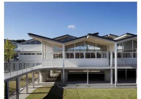
高床化による校舎への浸水対策
