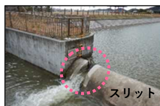
▲スリットの設置状況
