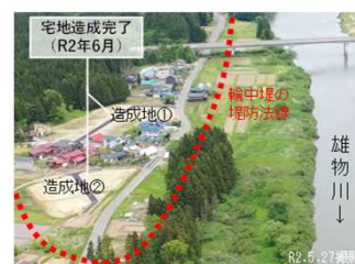
移転先宅地造成完了状況
