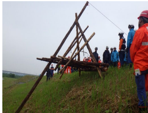
水防工法の実演① （川倉工）
