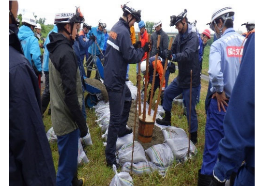
水防工法の実演③ （積み土のう工）
