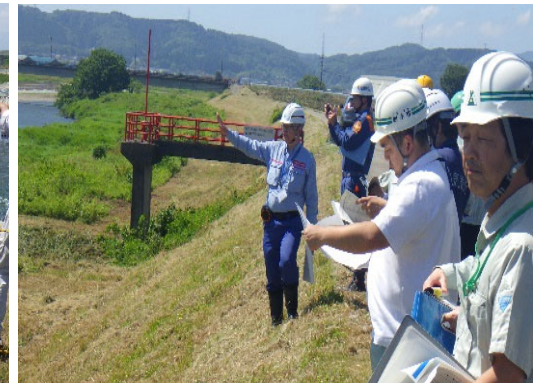
小矢部川 右岸31.0k付近 (小矢部市浅地地先)
