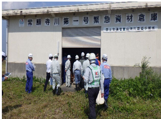
常願寺川 緊急防災資材倉庫第1号 (富山市水橋入部地先)
