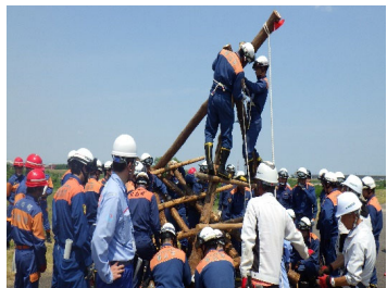
水防工法の実演① （川倉工）
