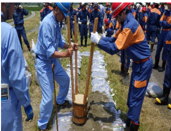
水防工法の実演③ （積み土のう工）
