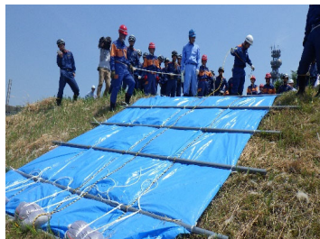
水防工法の実演② （シート張り工）
