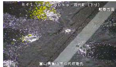
国道41号富山市双代町
