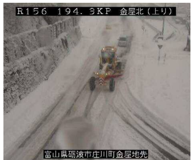
除雪グレーダによる除雪作業
