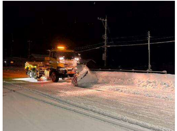
通行止め区間の除雪
