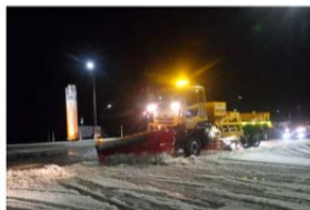
国道8号 小矢部市桜町における作業状況
