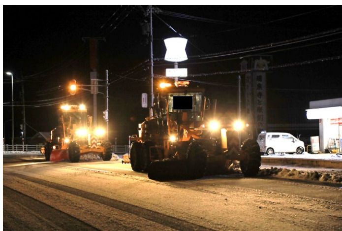
国道156号 砺波市庄川町示野地内
