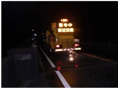
国道41号富山市蟹寺における作業状況
