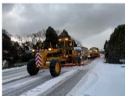
国道8号 朝日町境における作業状況
