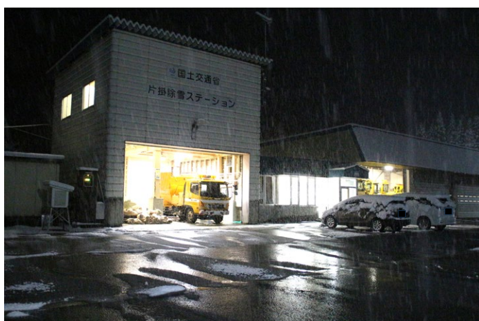
国道41号 片掛除雪ステーション
