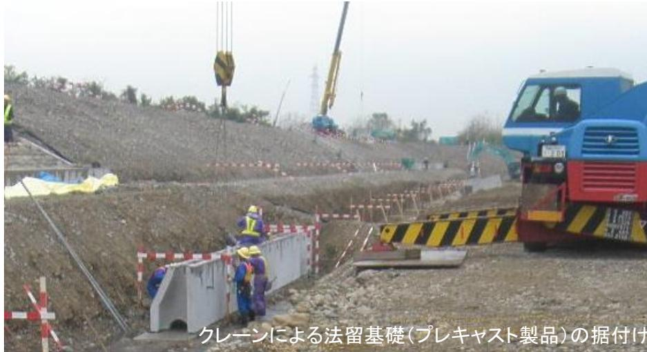
クレーンによる法留基礎(プレキャスト製品)の据付け
