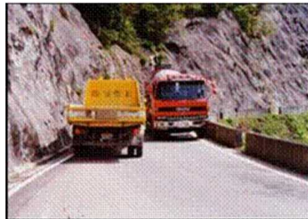
一般国道471号(現道)
