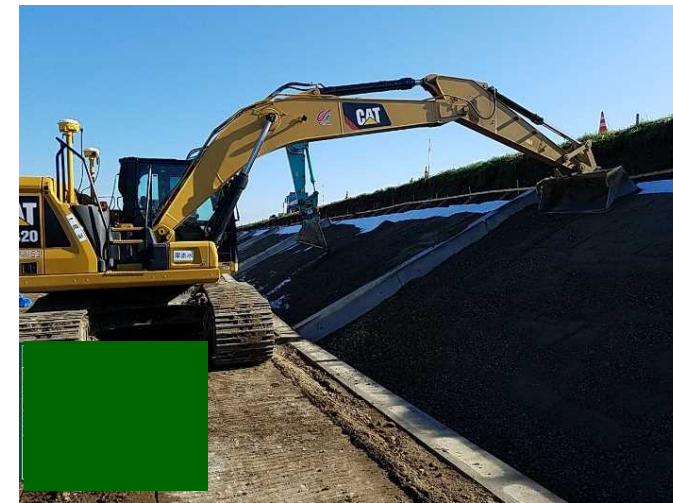
ICT機械による施工 (法面整形工)
