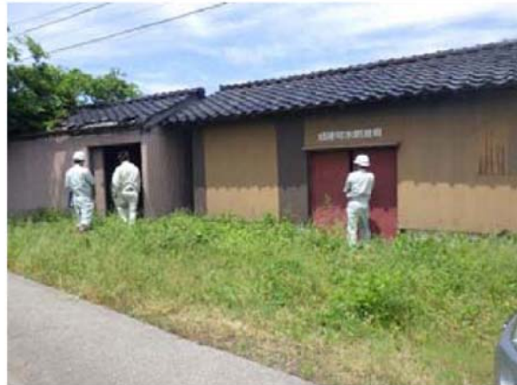
水防備蓄資材の点検(池川)
