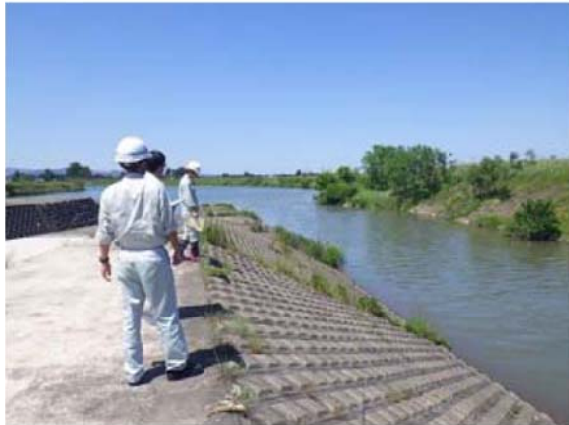
河川管理施設の点検(旅川)
