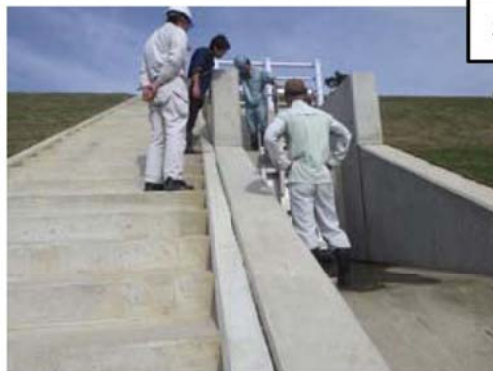
五ヶ村排水樋門の構造確認
