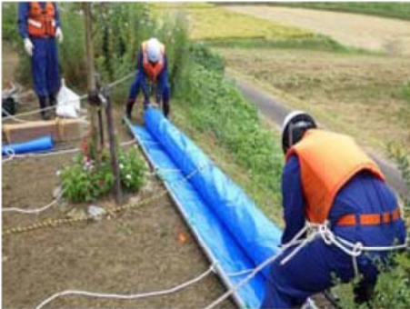
シート張り工法
