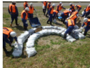
水防団による水防訓練 〈月の輪工〉
