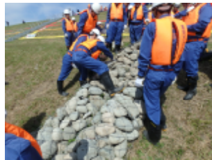
水防団による水防訓練 〈立籠工〉
