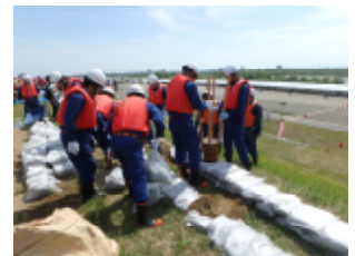
水防団による水防訓練 〈積み土のう工〉
