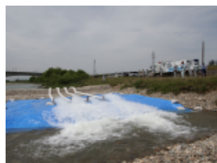
TEC-FORCEによる 緊急排水活動訓練
