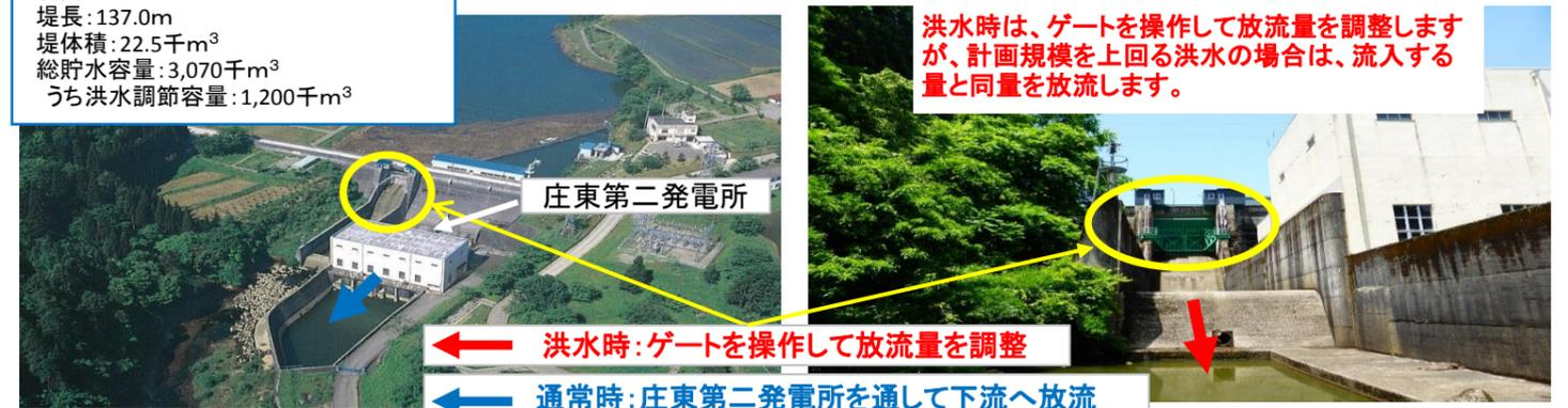
洪水時は、ゲート进行操作して放流量を調整しますが、計画規模を上回る洪水の場合は、流入する量と同量を放流します。
