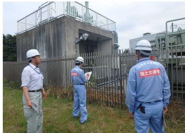
有沢水門(市)排水ポンプ場確認の様子
