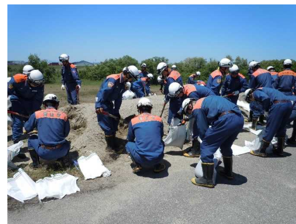
積み土のう工
