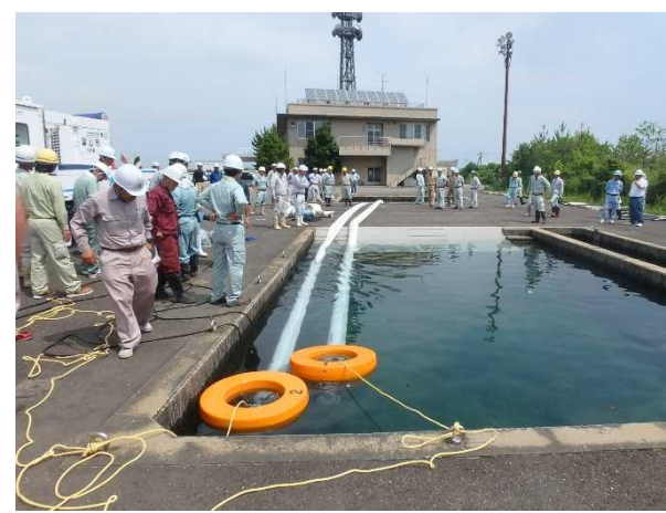
排水ポンプ車の試運転
