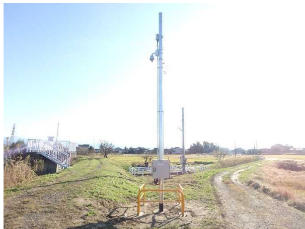
河川監視カメラ 設置状況
