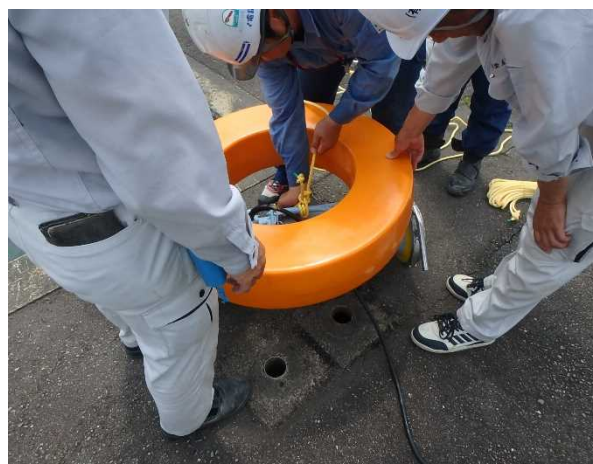
排水ポンプとホース・フロート取り付けの様子
