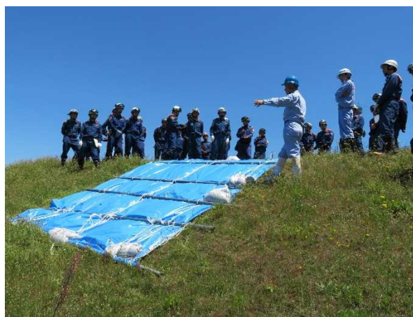
シート張り工
