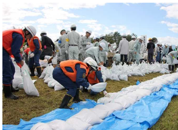
改良積み土のう工法
