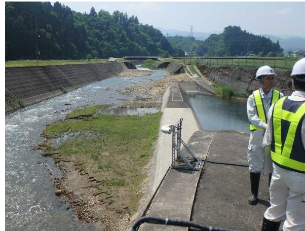
河川管理施設(放水路分水堰)の点検
