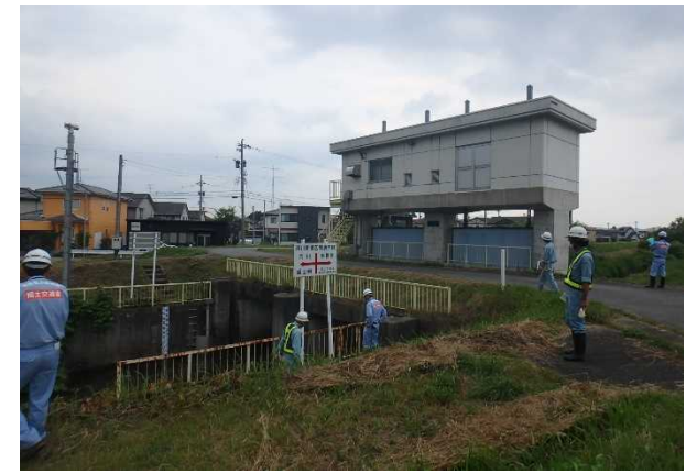
荒川樋門(国)周辺の状況確認の様子
