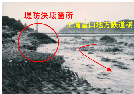
岩嶺野地先破堤状況
