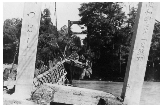
小矢部市津沢地先 (S28.9洪水)
