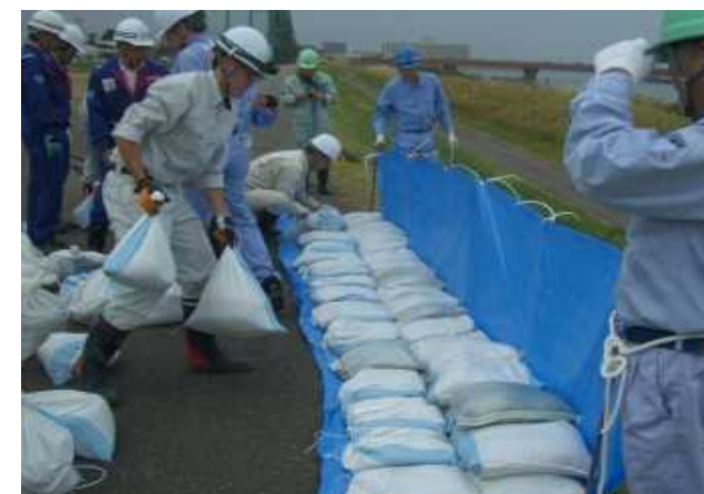
「改良積土のう工」
