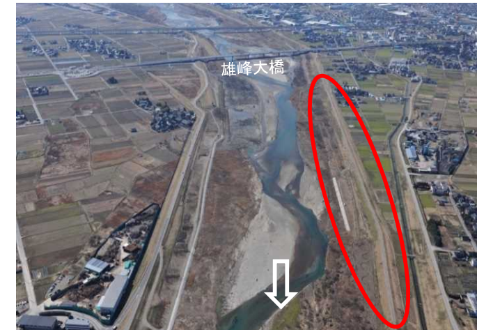
【常願寺川】富山市一本木地先 L=2,030m
