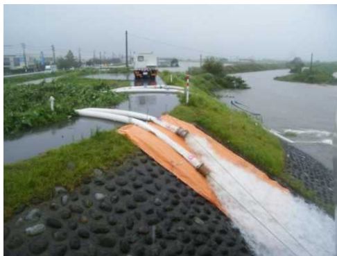
ポンプ車による排水 (磯川樋門)
