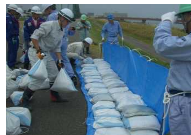
「改良積土のう工」
