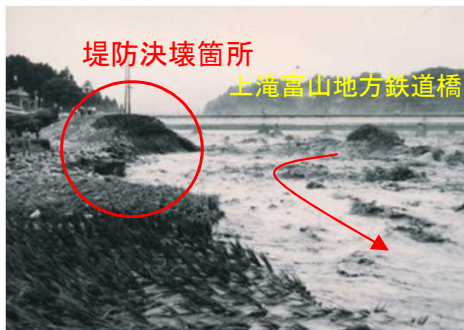
岩嶺野地先破堤状況
