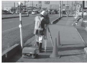
写真 用地幅杭打設作業の様子
