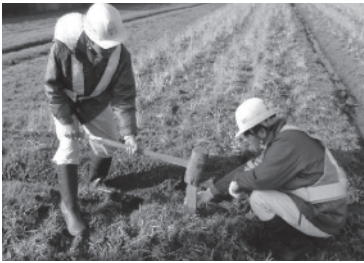
写真 用地幅杭打設作業の様子
