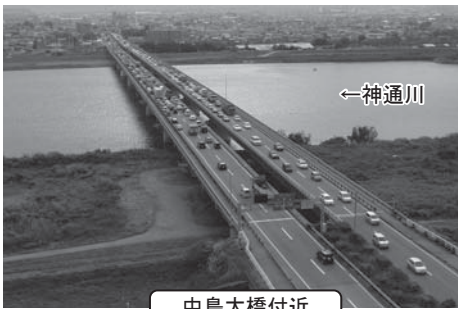
中島大橋付近
