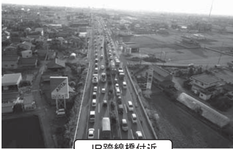
JR跨線橋付近
