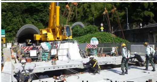
清水谷橋の施工状況(金沢森本IC～小矢部IC間)
