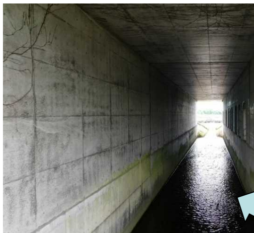
点検困難な水路BOX
