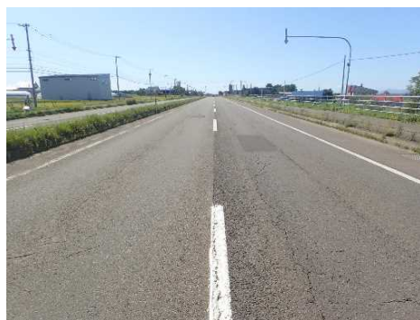
国道234号 岩見沢市栗沢付近 施工前の状況
