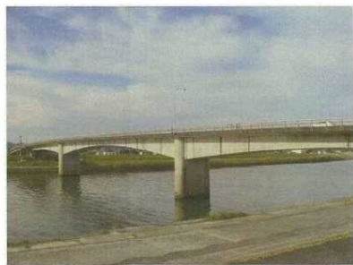
<天大橋の状況>
