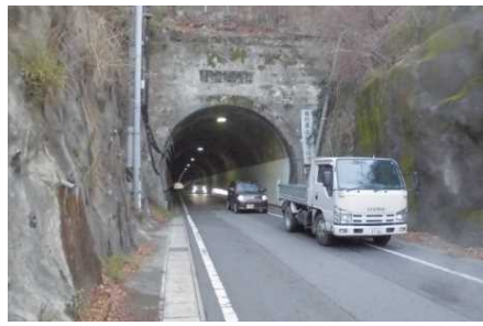
<仁方隧道の状況>
