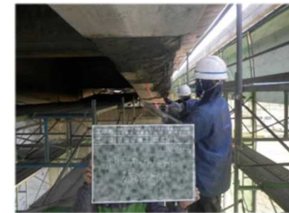
修繕の様子(断面修復)
