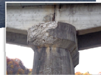
主桁・橋脚の損傷
