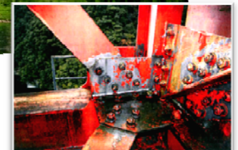
主桁の腐食
