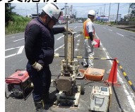
(貫入試験による調査)
