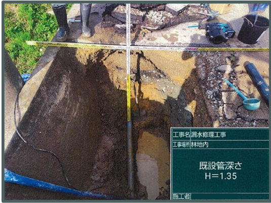
漏水箇所修理中
