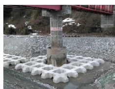
〈根固めブロック設置〉
