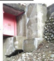
〈ひび割れ補修〉
