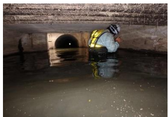
滞水した溝橋内部の目視点検
