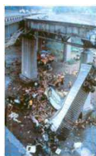
ケーブル切断事故後、通行止めになったブルックリン橋の歩道（「高速道路と自動車」1981年11月から引用）
