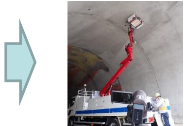
レーザー打音による変状の把握
