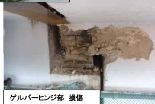
橋脚 断面欠損と鉄筋露出
