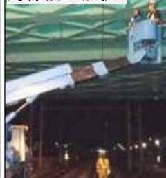
跨線橋の点検
