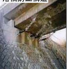
落橋防止構造
