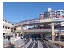
＜連続立体交差事業＞
