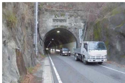
<仁方隧道の状況>
