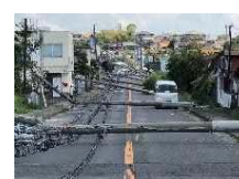
＜電柱倒壊による道路閉塞＞
