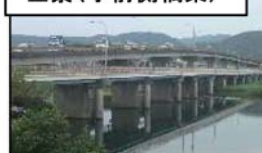
全景(手前側橋梁)
