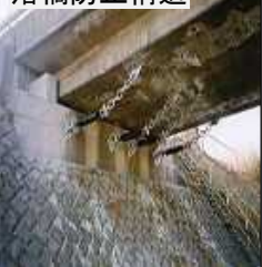
落橋防止構造
