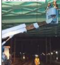
跨線橋の点検
