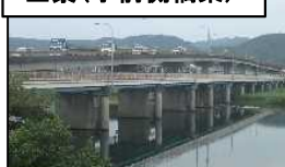
全景(手前側橋梁)
