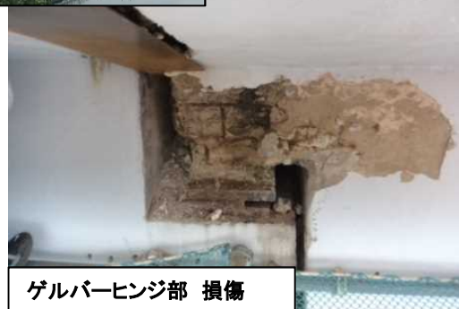
橋脚 断面欠損と鉄筋露出
