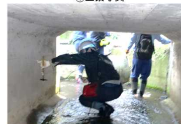
②点検の様子
