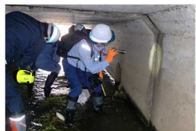
②点検の様子
