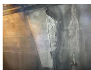
▲トンネル目地部
