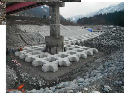
修繕代行事業による工事
