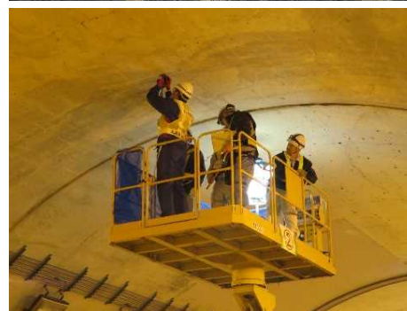
トンネル点検現地講習会
