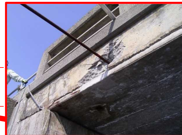
(海側) PC鋼棒 φ23, L=3m突出
