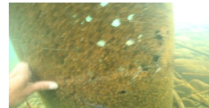
鋼管の腐食状況
