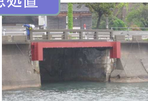
応急処置後の状況
