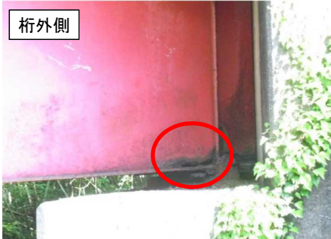
桁外側からの近接目視の状況 (変状の確認は困難)
