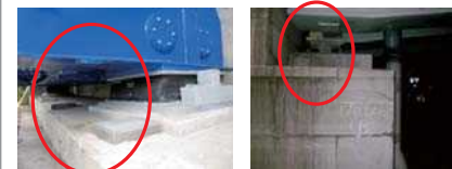
ジャッキアップに配慮した構造
