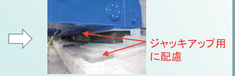
支保交換が容易な構造の例
