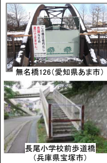
通行止め橋梁
