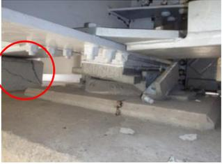
写真-6 支承の破損の状況
