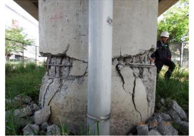
写真-7 段落し部の損傷
