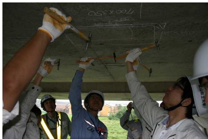
点検ハンマーによる打音調査を行っている状況
