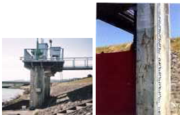
写真 3.1 排水樋管門柱部のクラック発生状況
