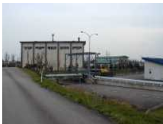
写真 3.2 四屋排水機場
