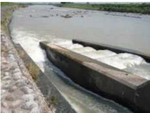
写真 2.14 三日市頭首工
