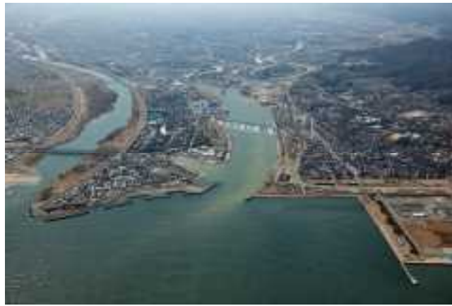
写真 3.5 河口部の土砂堆積状況
