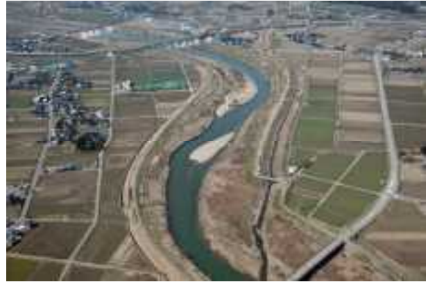
写真 2.8 河口から約 13km より上流の湾曲区間
