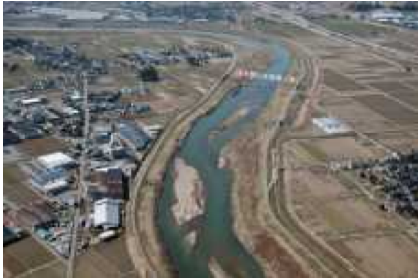
写真 2.7 河口から約 10km より下流の湾曲区間
