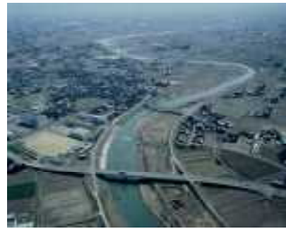
写真 2.6 津沢地点（35km 付近）の蛇行の状況
