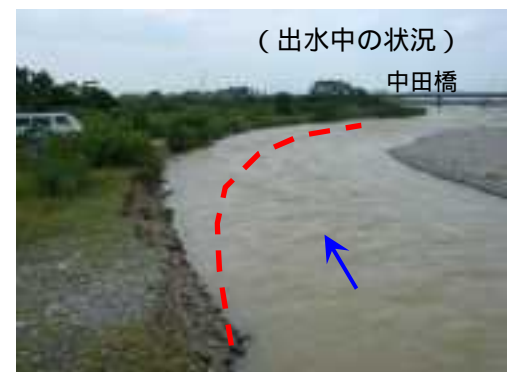
写真 3.7 河岸侵食状況
