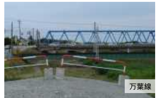
写真 3.4 万葉線桁下不足
