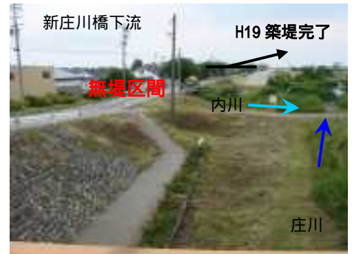
写真 3.3 無堤危険箇所
