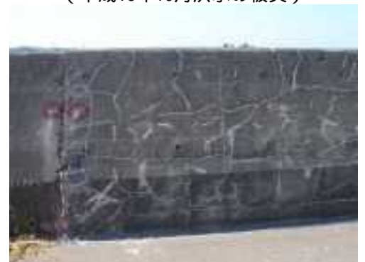
写真 3.2 河口部の特殊堤
