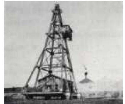
写真 2.5 タワーエクスキャベーターによる河床掘削
