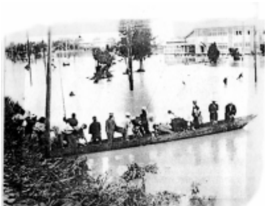
写真 2.2 昭和 9 年 7 月洪水 旧大門小学校（射水市大門町）
