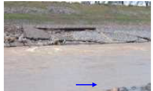
写真 3.1 堤防護岸欠壊及び根固流出 (平成16年10月洪水の被災)
