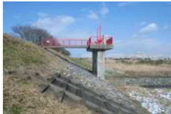
写真 3.10 許可工作物（仲井川排水樋管）
