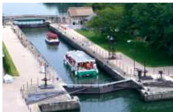
写真 2.1.3 中島閘門(国の重要文化財)
