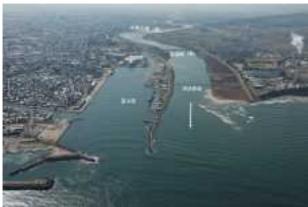
写真 3.5 河口部の土砂堆積状況
