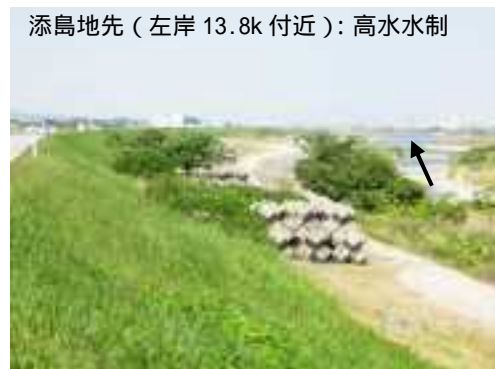
写真 3.4 急流河川対策実施例 (高水水制)
