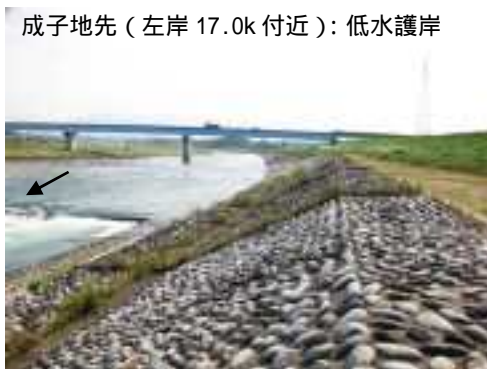
写真 3.3 急流河川対策実施例 (低水護岸)
