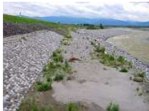
写真 3.2 護岸整備状況
