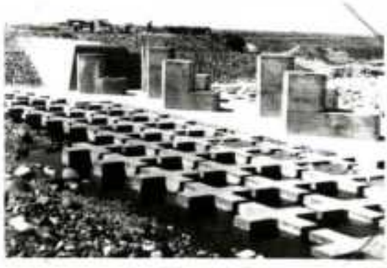
写真 2.4 巨大水制群と根固工
