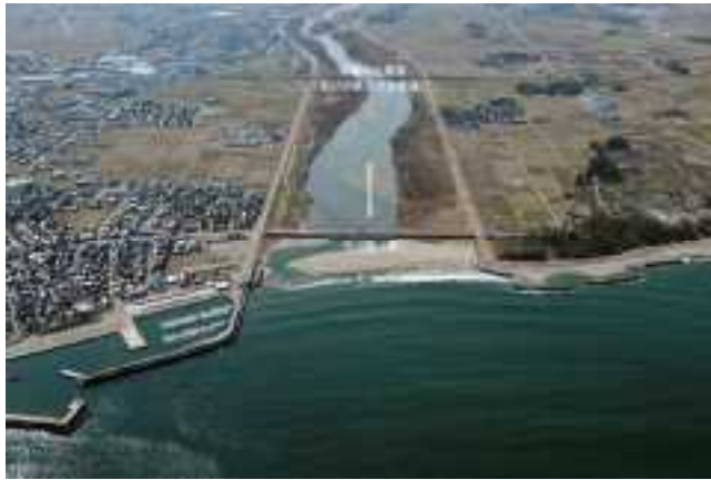
写真 3.6 河口部の土砂堆積状況
