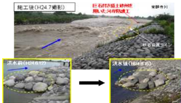
写真 3.4 巨石付き盛土砂州の施工状況
