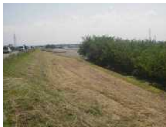
写真 2.11 3.1km 右岸付近の樹木繁茂状況
