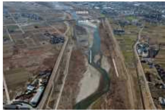
写真 2.2 河口から約 3km より上流
