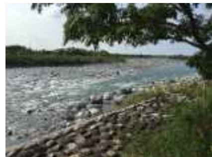
写真 3.5 巨石付き盛土砂州の一部流出
