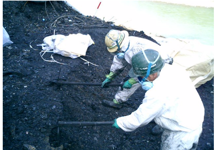
写真② 固く締まった焼却灰をほぐす作業(人力)
