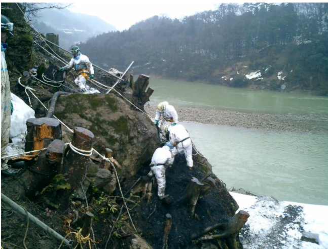
写真① 急峻な地形での搬出作業
