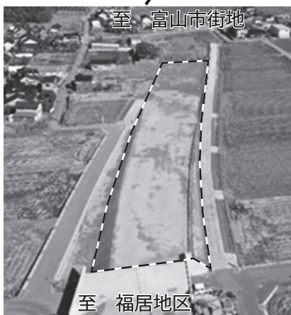
【惣在寺地区盛土工】
